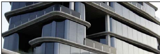
-Vista exterior del edificio -
