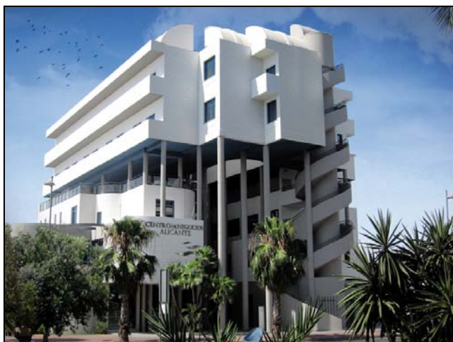
-Vista exterior del edificio -
